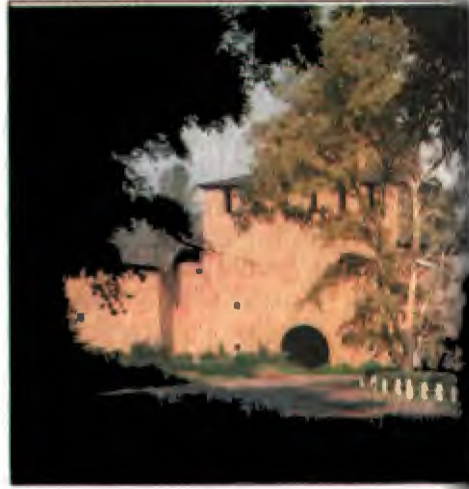
Ивановский спуск на территории нижегородского кремля. Впереди Ивановская башня. В ее ворота выходило ополчение под водительством Минина и Пожарского
